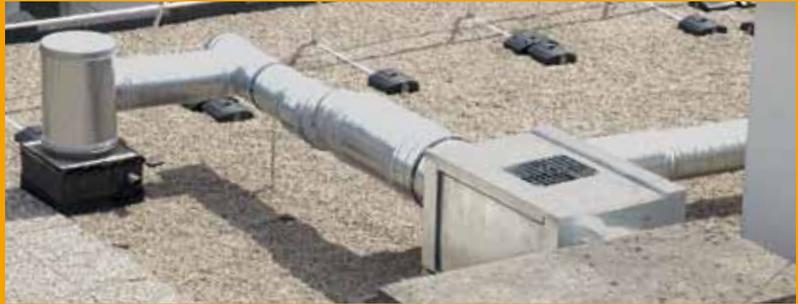
Apparue dans les années 1970, la VMC-gaz est une déclinaison du système VMC simple flux. Elle permet d'extraire, dans le même conduit de ventilation, l'air vicié du logement et les produits de combustion de l'appareil à gaz.
