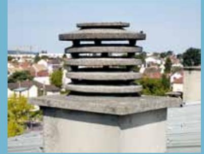
Les SHUNT et les conduits Alsa maçonnés fréquemment mis en œuvre sont construits entre autres en maçonnerie. Ils peuvent être soit démontés...
